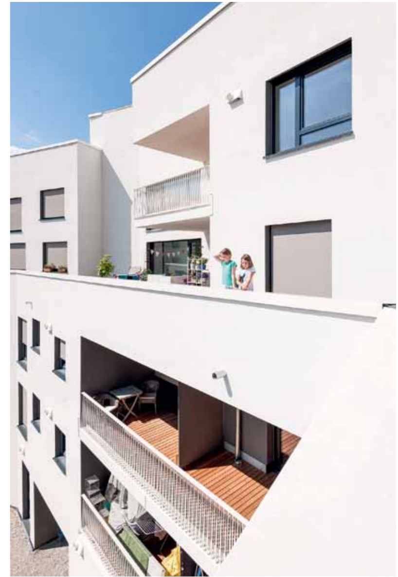
Blick von einer der umlaufenden Erschließungen auf den Hof. Fotos: Jullia Knop
