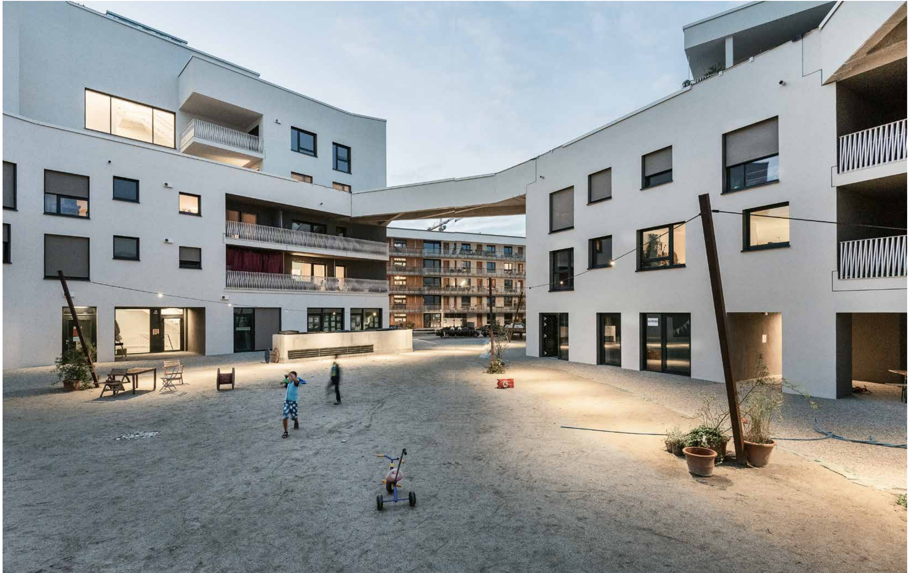
Die differenzierte Gebäudestruktur bietet Platz für gemeinschaftliches Wohnen und Verbindungen zwischen innen und außen.
