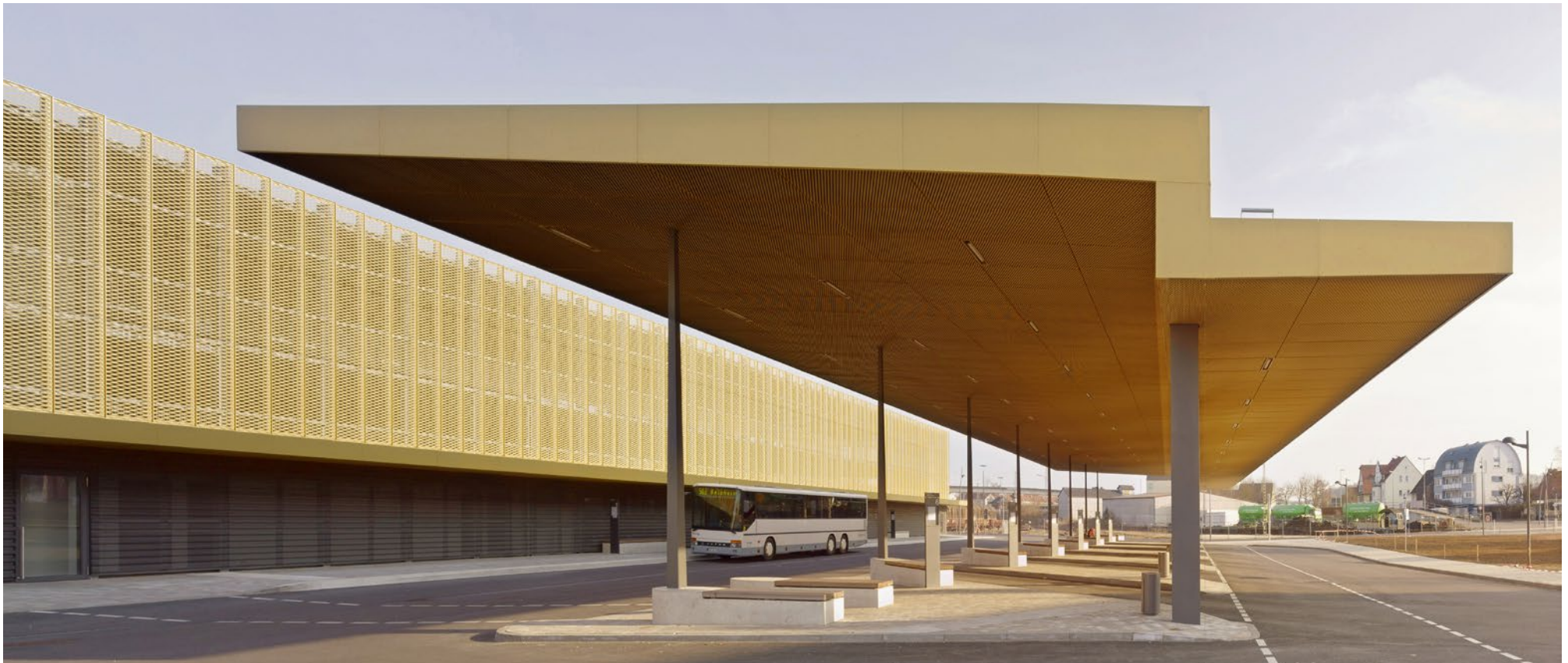
Busbahnhof und P+R Gebäude in Nördlingen von MORPHO-LOGIC Architektur + Stadtplanung, Foto: Michael Heinrich
